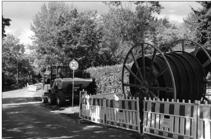
Diese Stromkabel werden, wie hier zurzeit in Wolfersdorf, unterirdisch verlegt und sorgen dafür, dass etwa zwei Kilometer Freileitung rund um Stockheim abgebaut werden können.
