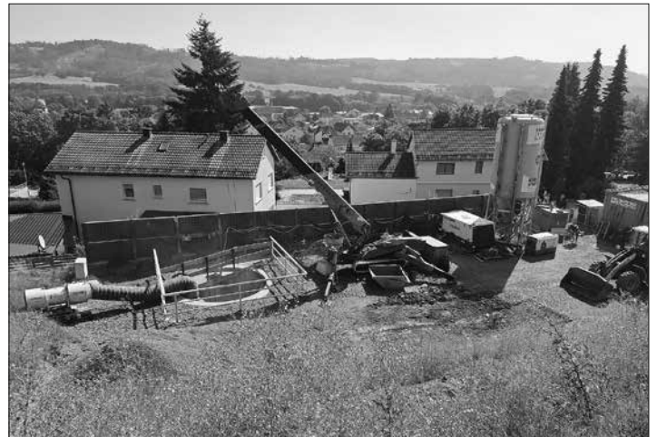
Bild: Baustelleneinrichtung und Schachtmundloch am Christopherschacht.
