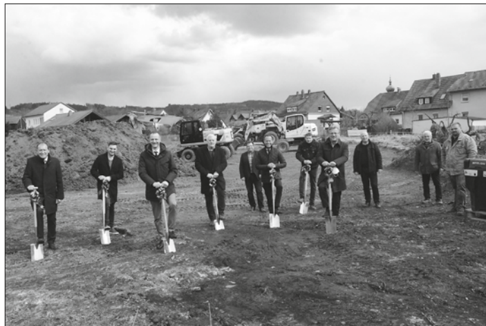
Sie freuen sich beim Spatenstich zum Bau einer Wohnanlage in der Ortsmitte von Stockheim. Von links Hans Ulrich Fuchs (Vorstand Raiffeisenbank), Niclas Wich (Wich Immobilien), Andy Schindhelm (Vorstand Raiffeisenbank), Architekt Wolfgang Feuerpfeil (Planer), Heiko Bernardo (vorne, Vorstand Raiffeisenbank) und Bürgermeister Rainer Detsch (vorne), mit weiteren Verantwortlichen der Baumaßnahme.
