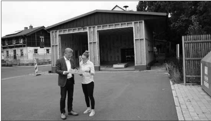
Bürgermeister Rainer Detsch und Kämmerin Eva Schießwohl bei der Baustellenbegehung des Feuerwehrrgerätehaus- Anbaus der FF Haßlach. In diesen Tagen werden Fliesenarbeiten und Arbeiten für die Außenanlagen vom Gemeinderat vergeben.
