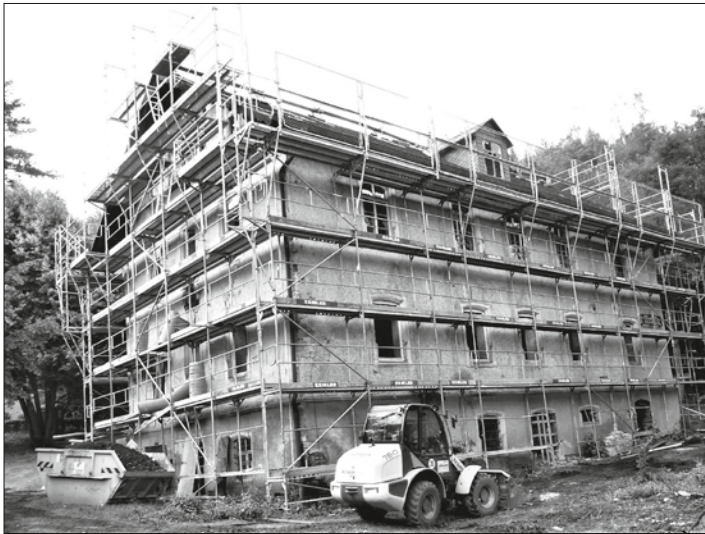
Für 2,7 Millionen Euro wird die Rentei (Verwaltungsgebäude) der ehemaligen Katharinazecher saniert.
