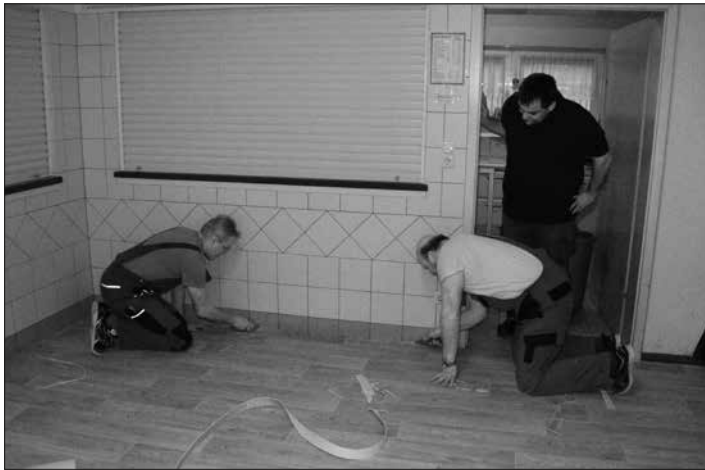
2. Vorsitzender Holger Bogdanski (stehend) beobachtet die letzten Arbeiten von Rainer Daum und Norbert Fleischmann (v.l.) beim Verlegen des neuen Fußbodenbelages in der Zecher-Halle.
