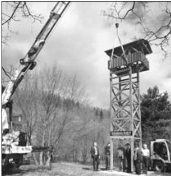
Dank ehrenamtlicher Initiative haben die Stockheimer wieder einen acht Meter hohen Förderturm. Links im Hintergrund die Rentei.
