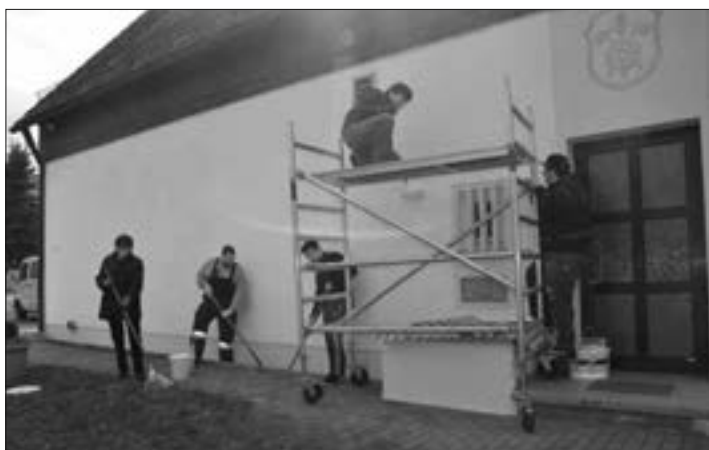
Hausputz bei der FF Haig. Petra Förtsch, Bastian Förtsch, Christian Heinlein, Georg Gremer und Adelbert Förtsch sorgen für neuen Anstrich an der Fassade des Feuerwehrgerätehauses. Bild: Karl-Heinz Hofmann
