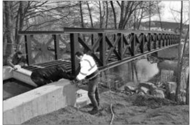
Der 23 Meter breite Engelessteg hat über den Haßlachfluss eine zwölf Tonnen schwere Stahlkonstruktion erhalten.
