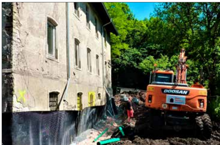
Aktuell werden im Außenbereich Abdichtungs-, Drainage- und Entfeuchtungsarbeiten durchgeführt.
