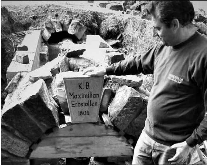
Den 30 Kilogramm schweren Schlussstein für das Röschenmundloch an der Haßlach aus Sandstein fertigte Steinmetzmeister und Restaurator Udo Deinlein aus Stockheim an.
