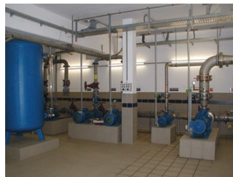
Moderne Trinkwassertechnik in der Aufbereitung
