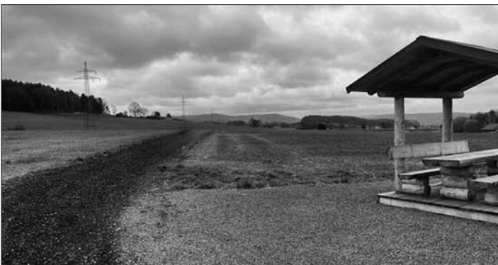
Fräsgut als günstige Möglichkeit, die Flurwege zu renovieren.
