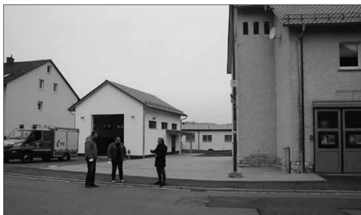
Bei der Übergabe der neuen Fahrzeughalle (links) der FF Reitsch, von links 1. Kommandant Matthias Keim, Dirk Raupach (Bauamtsleiter) und Bürgermeister Rainer Detsch, rechts ist ein Teilstück des alten Feuerwehrhauses zu sehen in das viel Eigenleistung in ehrenamtlicher Arbeit der Feuerwehrleute geopfert wurde.
