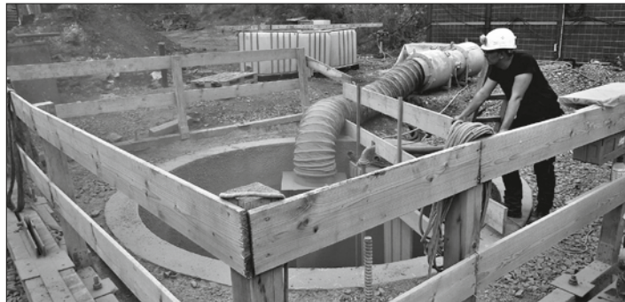
Wieder geöffnet wird der ehemalige Förderschacht der Zeche St. Katharina bis auf 35 Meter.
