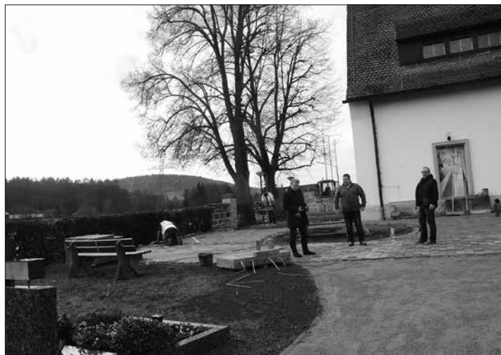
Gelungene Friedhofsbaumaßnahmen in Haig. Bürgermeister Rainer Detsch und Bauamtsleiter Dirk Raupach (von links) zeigen sich sehr zufrieden mit den Bauausführungen und danken Firmeninhaber Michael Haderlein (rechts) für die gute Zusammenarbeit und gelungene Bauausführung.
