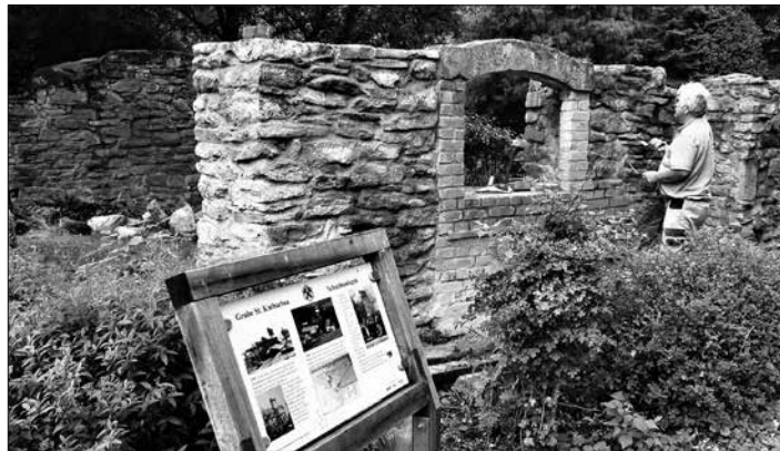
Mit hohem Zeitaufwand saniert Rembert Müller die Außenmauerung des ehemaligen Kessel- und Maschinenhauses der Zeche St. Katharina.
