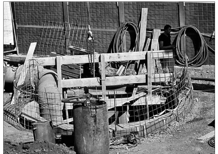
Gut abgesichert ist der Zugangsschacht. Im Vordergrund sichtbar ein Teufkübel für Materialbeförderung.
