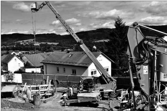
Oberhalb des Stockheimer Friedhofs wird ein 30 Meter tiefer Zugangsschacht zum Königlich-bayerischen Maximilian Erbstollen abgeteuft.
